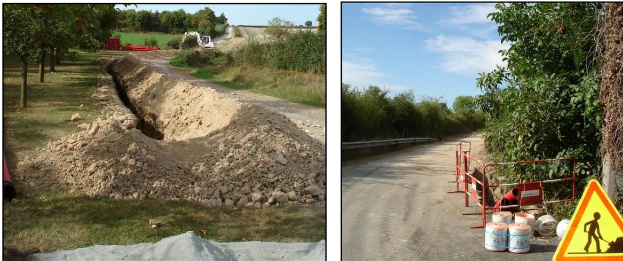
Tranchée pour le raccordement au réseau local (Source : VALOREM)
